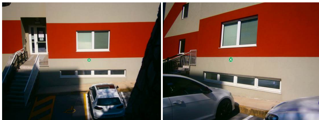
Foto n.5: Vista dell'edificio dall'esterno con segnalato il "Punto di raccolta" nell'area sotto l'edificio E2 bis
