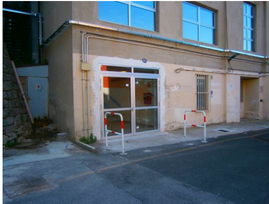
Foto n.3: Vista dell'ingresso dal varco n. 1
