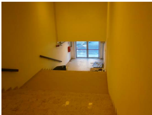
Foto n.8: Vista dell'uscita di emergenza che conduce all'area di raccolta sotto l'edificio E2 bis
