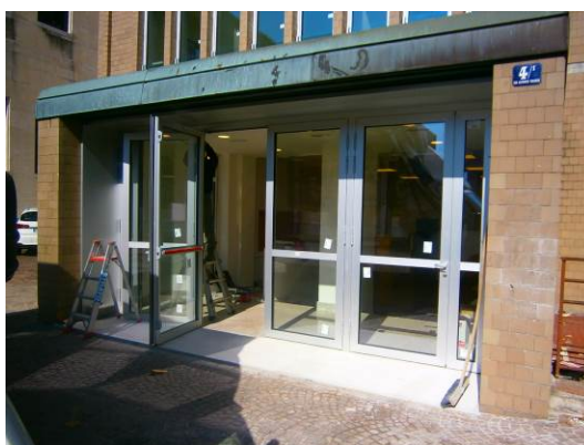
Foto n.2: Vista dell'ingresso principale da piazzale Europa
