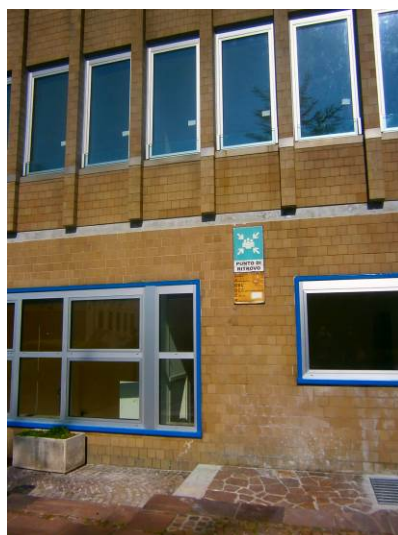
Foto n.4: Vista dell'edificio dall'esterno con segnalato il "Punto di raccolta" nel giardino di fronte all'entrata principale (piazzale Europa)
