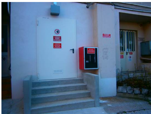
Foto n.10: Vista dell'attacco per la motopompa dei VV.F.
